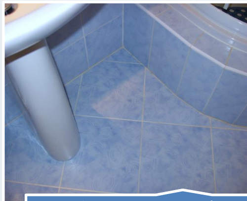
Izolacja pomieszczeń wilgotnych
